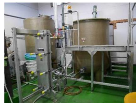
プレート式熱交換器・大型タンク・攪拌機等
